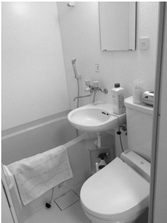
写真 19 施設 F(助産所・中部地方) 浴室
